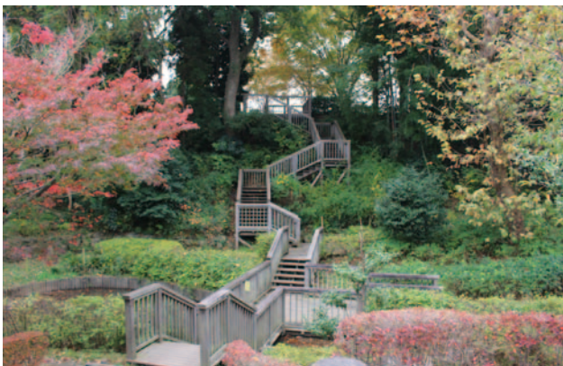
ウッドデッキ階段
